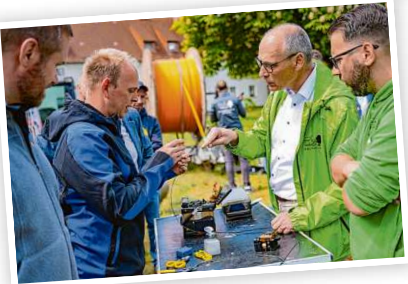
Und so kommt das Glasfaserkabel später ins Leerrohr. Fachkundige Erläuterungen.
